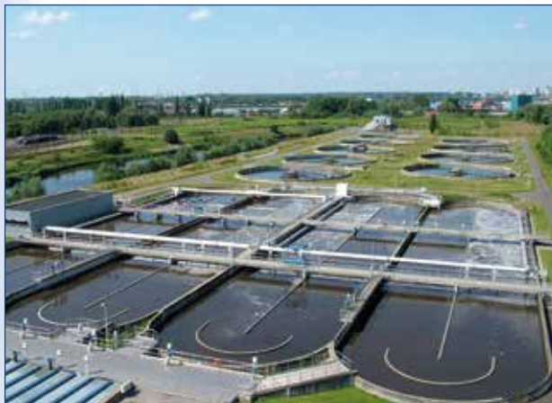
Imagen de EDAR (Estación Depuradora de Aguas Residuales)
