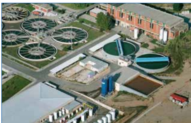
Imagen de ETAP (Estación de Tratamiento de Agua Potable)
