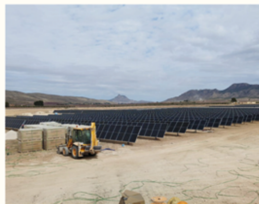
Construcción fotovoltaica realizada por Visalia en Jumilla, Murcia.
