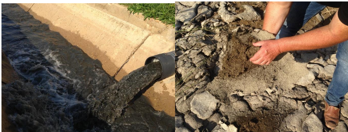
Figura 64. Vaciado de tuberías por desagües hacia acequia secundaria (izquierda). Formación de aglomeraciones de briozoos y sedimentos disecados tras las primeras operaciones de sobrevelocidades. Fuente: C.R. Valle Inferior del Guadalquivir.
