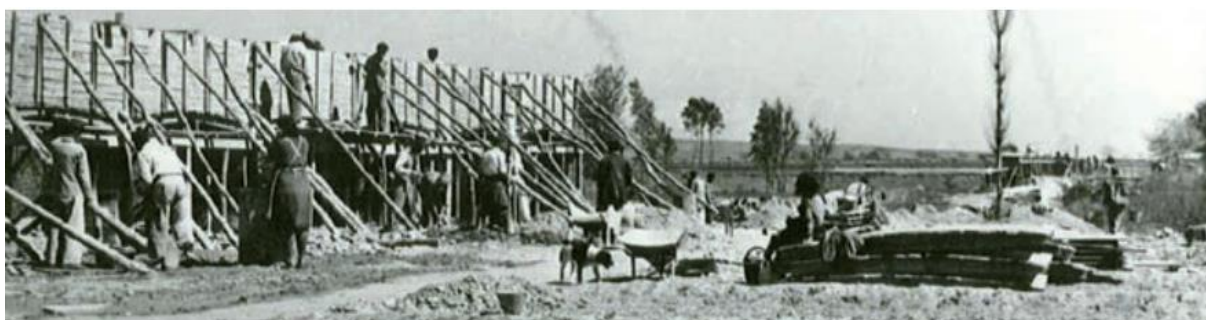
Figura 20. Obra de construcción de un acueducto. Fuente: Archivo C.R. Valle Inferior del Guadalquivir
