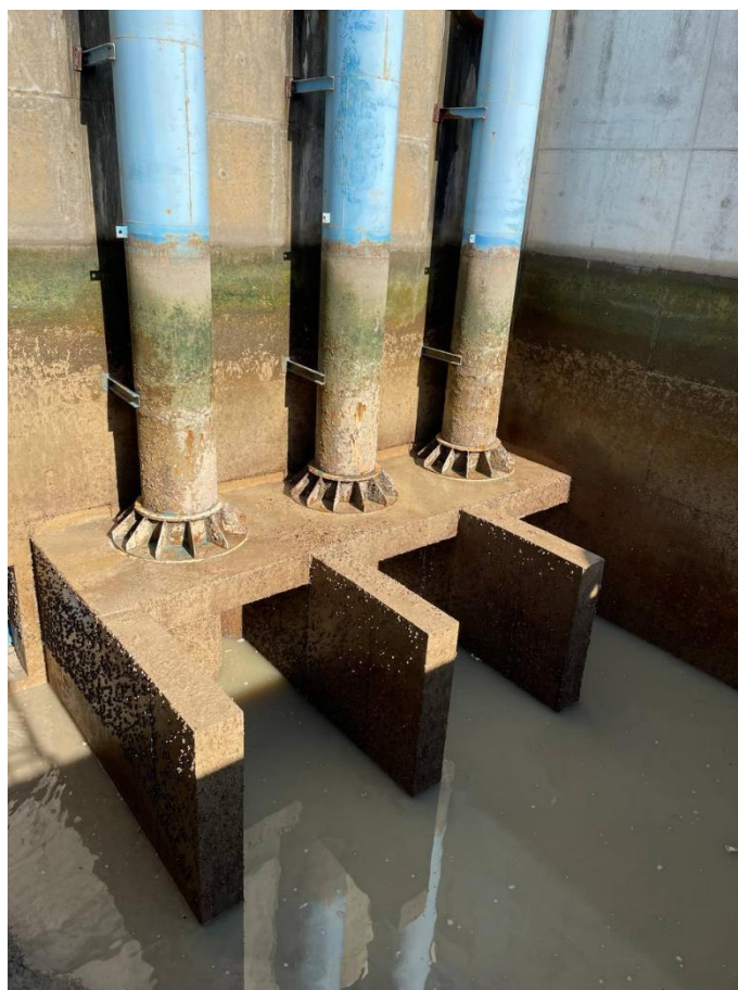
Figura 47. Ejemplares de mejillones adultos incrustados en las troneras de las bombas de llenado de balsa (Sector VIII). Fuente: C.R. Valle Inferior del Guadalquivir.
