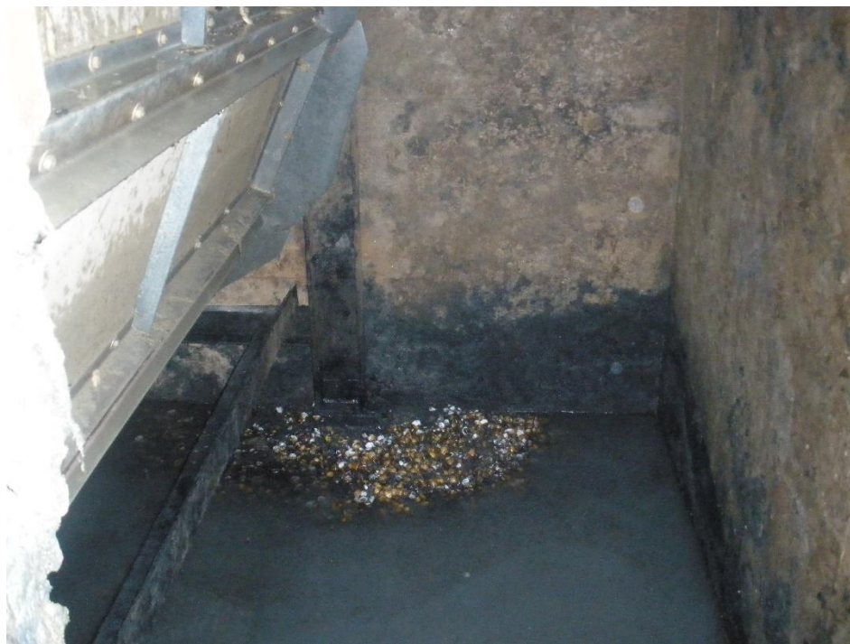
Figura 40. Foco de individuos de almeja asiática muertos en la cántara del filtro rotativo de cadenas. Fuente: C.R. Valle Inferior del Guadalquivir.
