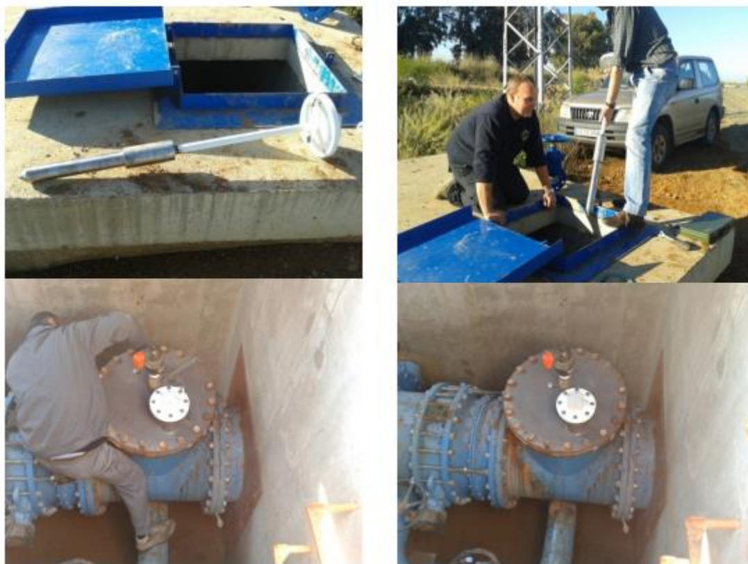
Figura 52. Instalación de un equipo ultrasónico en una tubería afectada por la plaga de briozoos en el Sector VI. Fuente: Toscano Línea Electrónica, S.L.
