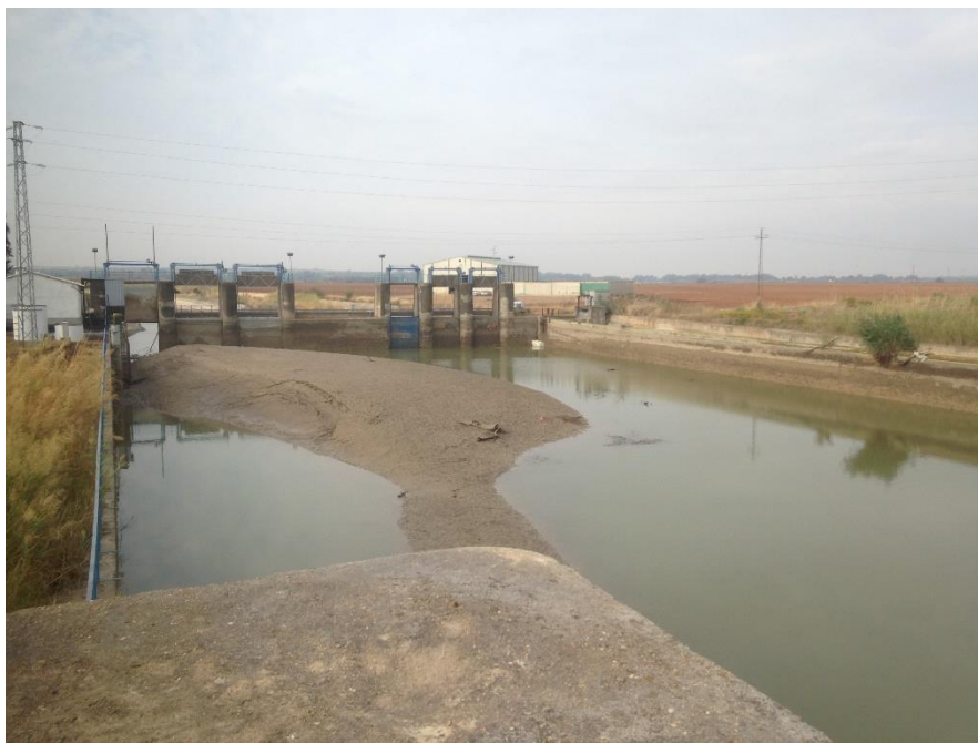
Figura 3. Acumulación de adultos de almeja asiática en el partidor El Cuenco sito. en la Zona Regable del Bajo Guadalquivir. Fuente: C.R. Valle Inferior del Guadalquivir.
