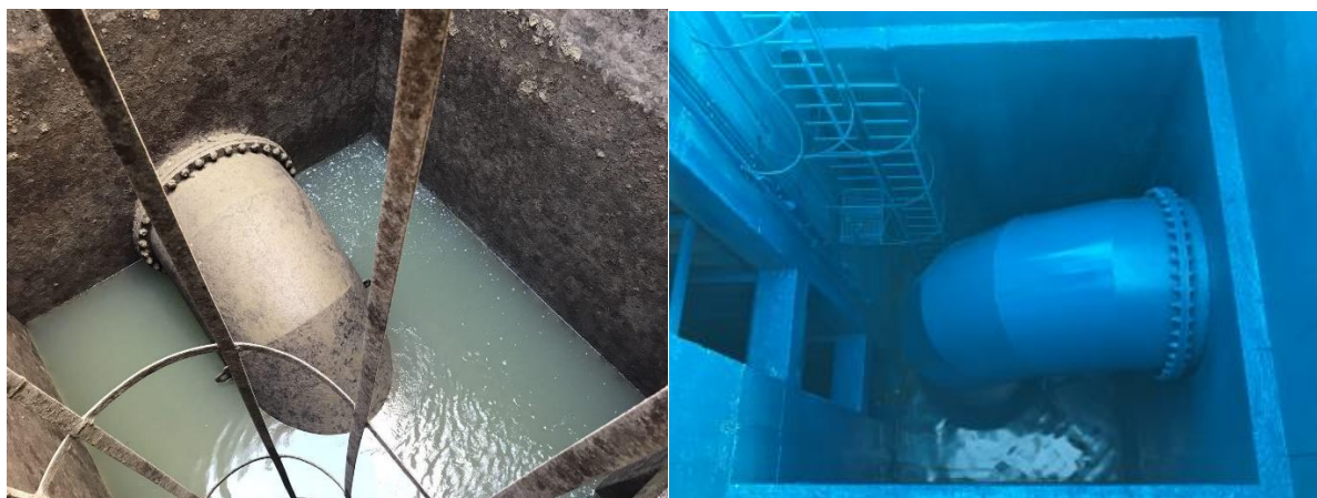
Figura 57. Cántara de filtrado antes y después del tratamiento de pintura antifouling. Fuente: C.R. Valle Inferior del Guadalquivir.
