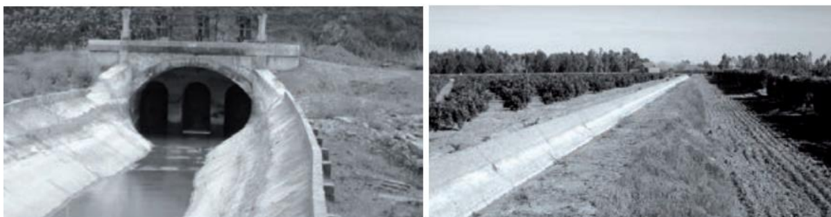
Figura 22. Revestimiento de acequias en los años 60. Fuente: Archivo C.R. Valle Inferior del Guadalquivir.
