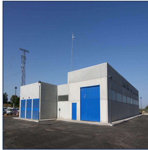
9 Estaciones de bombeo
