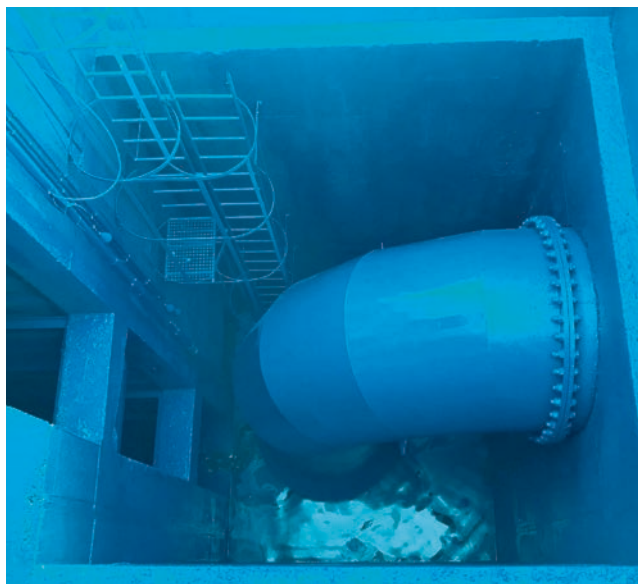
Aplicación de pintura antifouling en zonas de hormigón y estructuras metálicas de arqueta de filtro.
