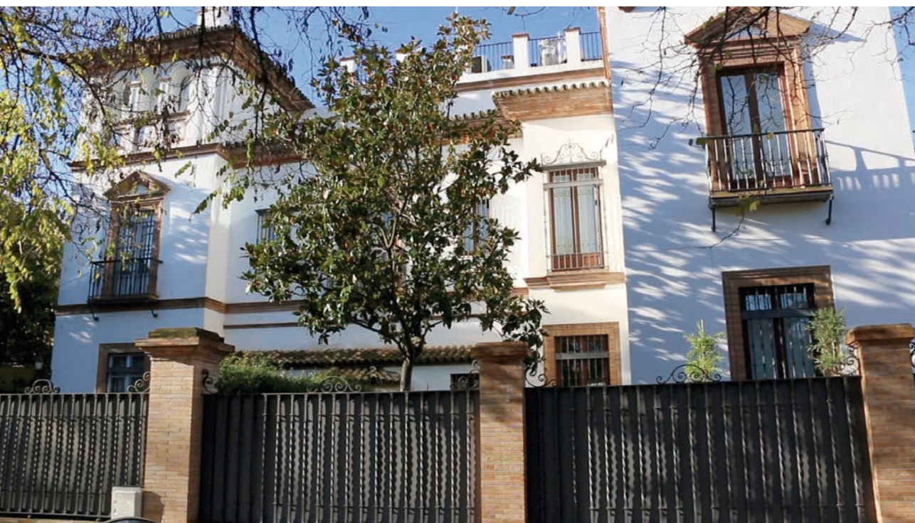
Fachada de la nueva sede.
