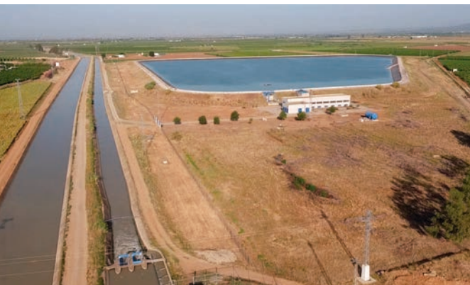
Canal principal, balsa y estación de bombeo.
