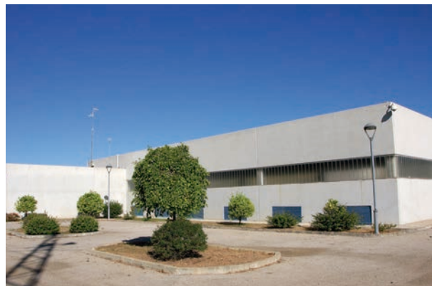
Edificio de estación de bombeo.
