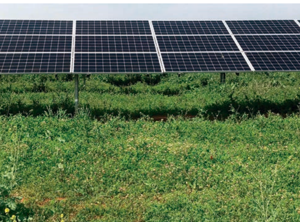
Cubierta vegetal implantada en el parque solar.
