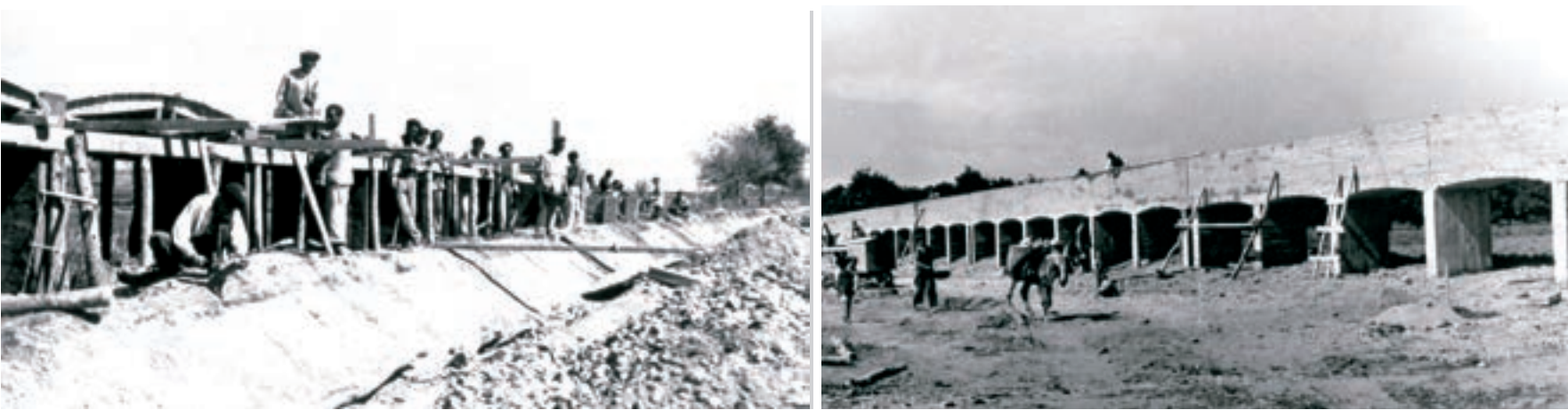
Imágenes antiguas de la construcción de las primeras infraestructuras para puesta en riego del Valle Inferior.
