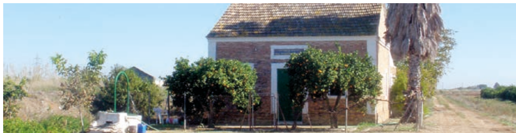
Casilla de guarda.
