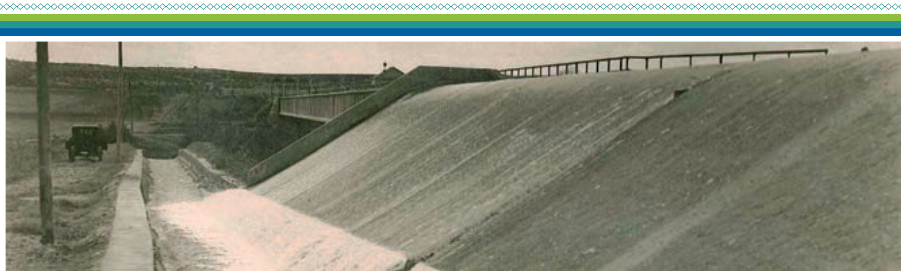
Vista general de un aliviadero.
