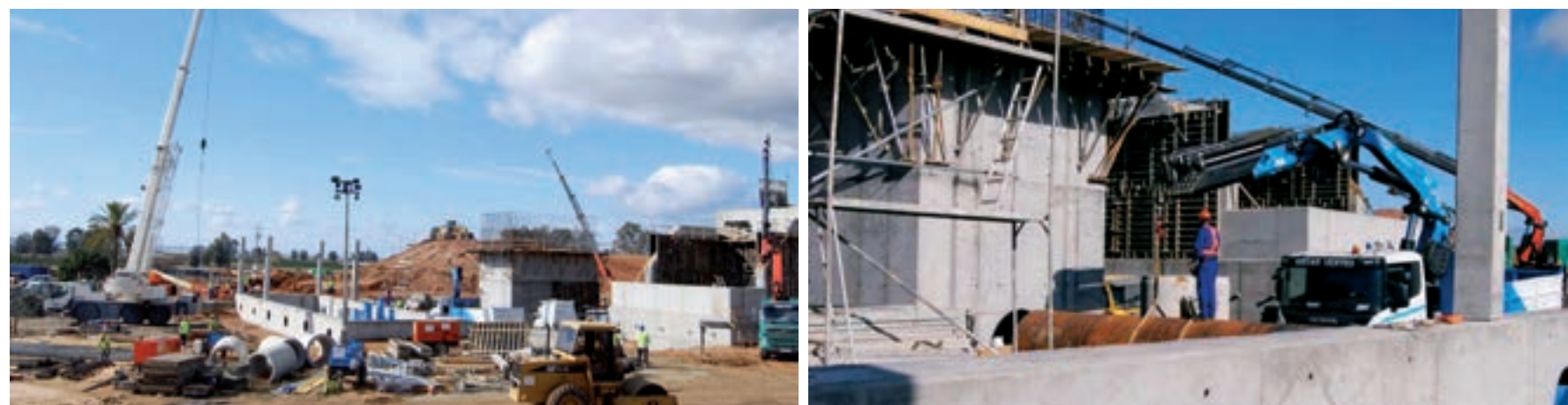
Obras de modernización.
