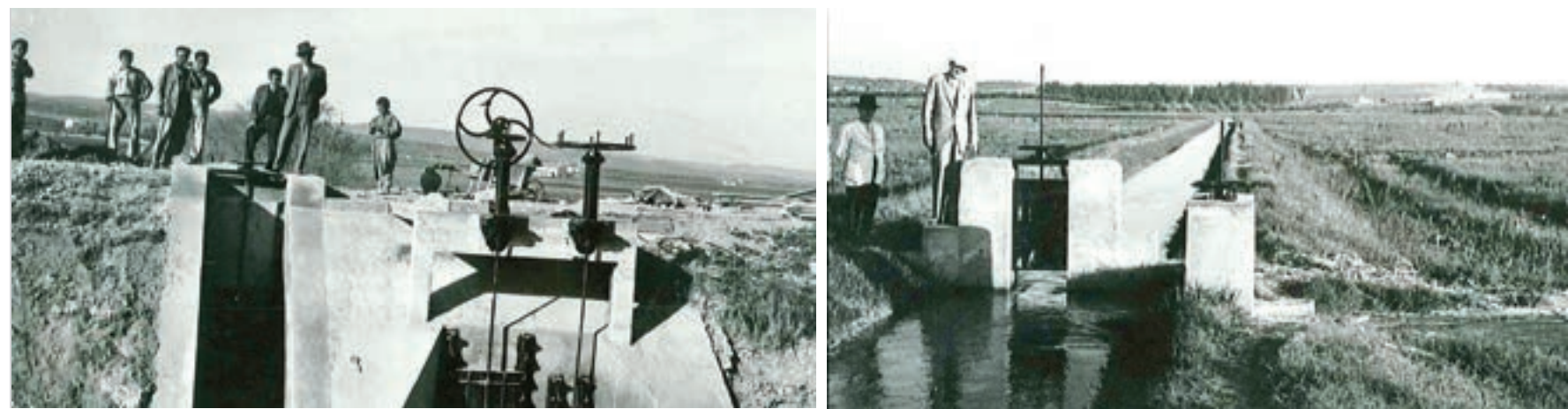
A la izquierda, imagen de una toma de acequia. A la derecha, un repartidor.
