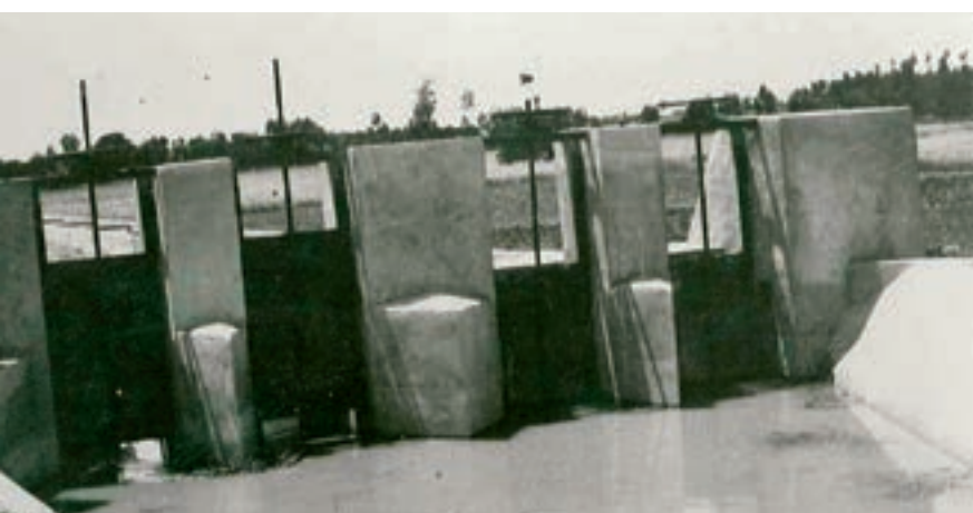
A la izquierda, obra de retenida en el Canal. A la derecha, cajero de un acueducto.
