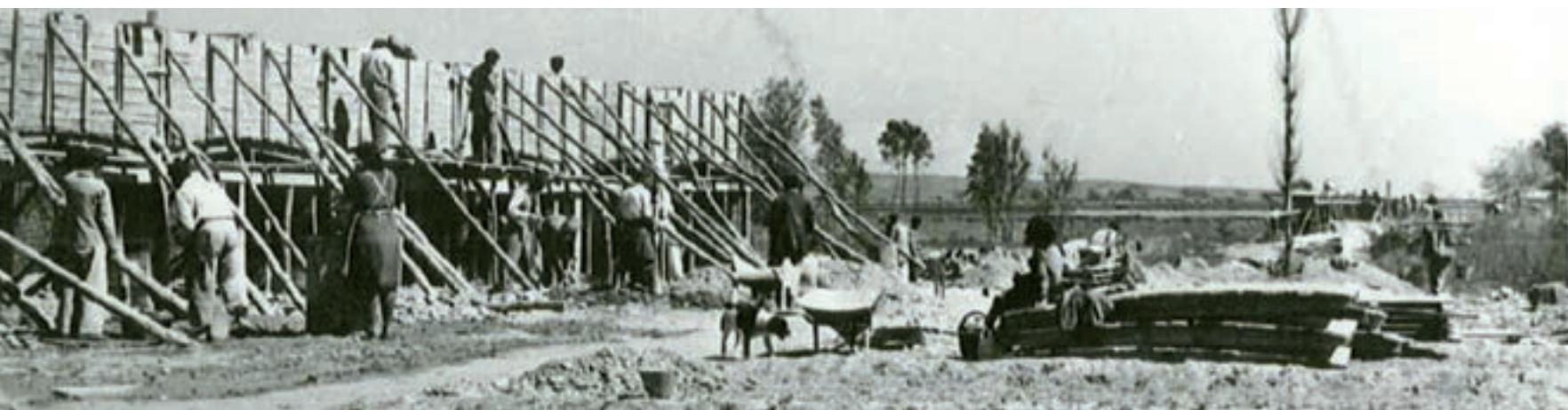
Obras de construcción de un acueducto.
