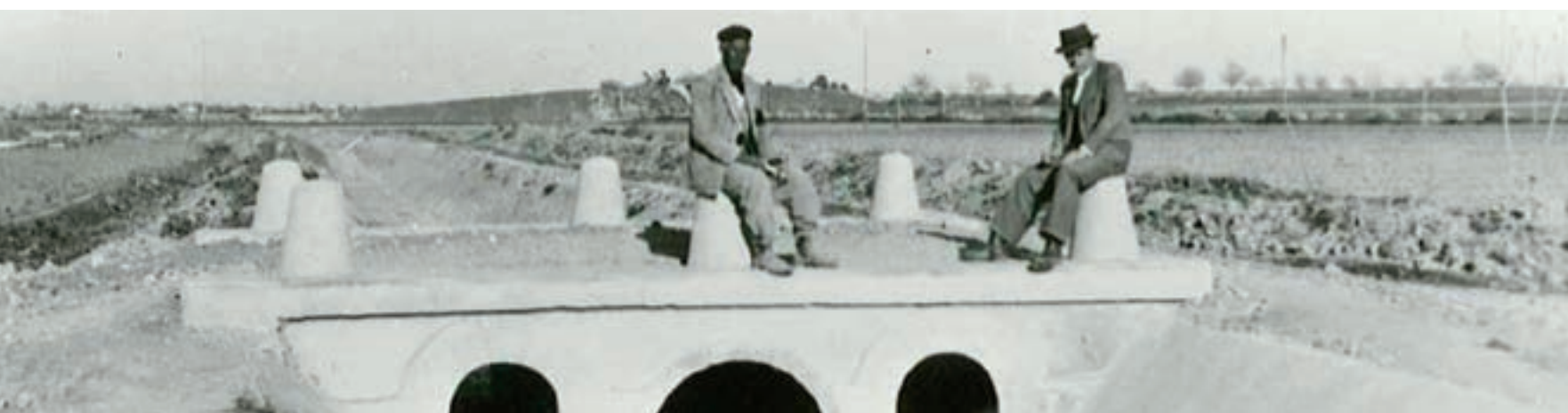
Puente sobre el canal principal.
